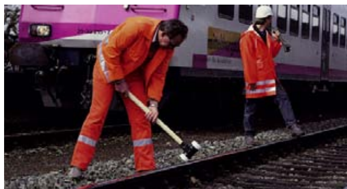
Powlekane proszkowo uchwyty wykonane z żeliwa ciągliwego bezpiecznie łączą główkę i trzonek. Młotek kowalski o długości 840 mm ma idealną długość dla zastosowań specjalnych, np. przy pracach torowych.
